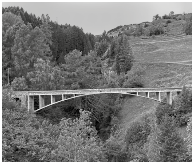
Die Valtschielbrücke in Donat von Robert Maillart. Foto Susanne Müller.
