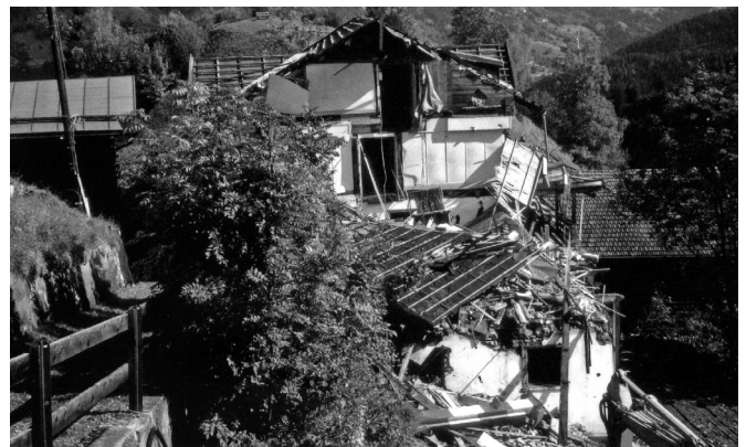
Sinnbild für den jahrelangen Niedergang der Tschiertscher Hotellerie: Abbruch des Hotels «Jäger» im Unterdorf im Jahre 2006 (in Betrieb von 1894-1983). Fotos Hanspeter Walser.
