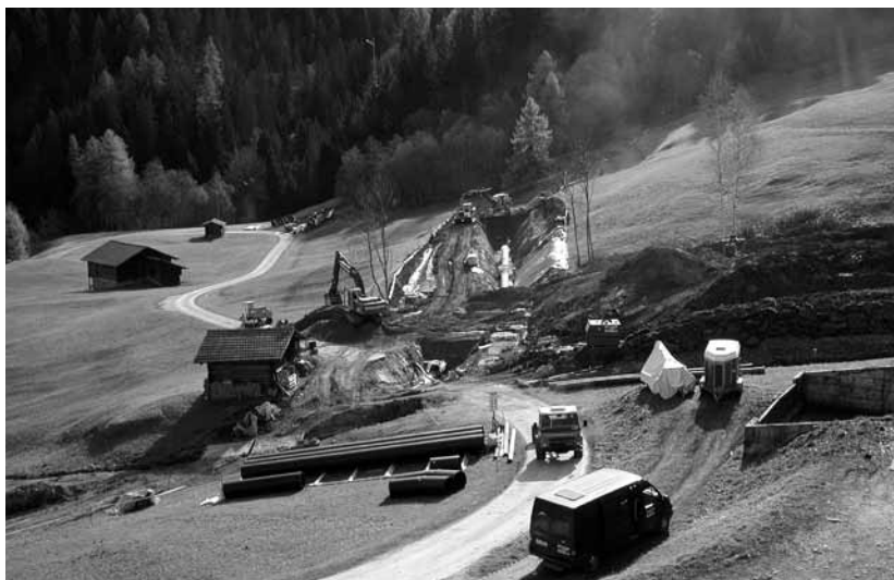
Die Bauarbeiten beim Wehr unterhalb der Tschierscher Säge sind voll im Gang. Bild: Christian Jenny
