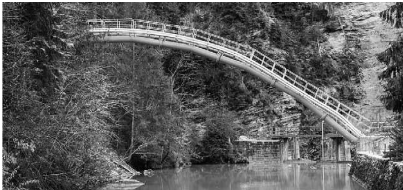
Rohrbrücke über die Plessur www.widmer-ing.ch/Referenzen/wasserkraft/neubau-kraftwerk-sagenbach
