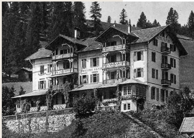
Das Hotel Alpina im Bauzustand von 1912. Die frühere Fassade soll wiederhergestellt werden. Fotos: Peter Knobel
