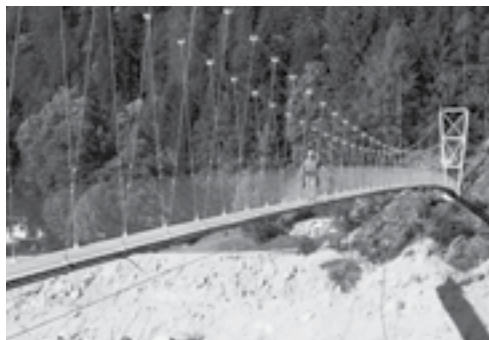
Neue Brücke Bondo. Foto: Hans Strassmann.
