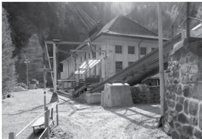
Das Kraftwerk Lünen versorgt Arosa und das Tal seit 1914 mit Elektrizität.
