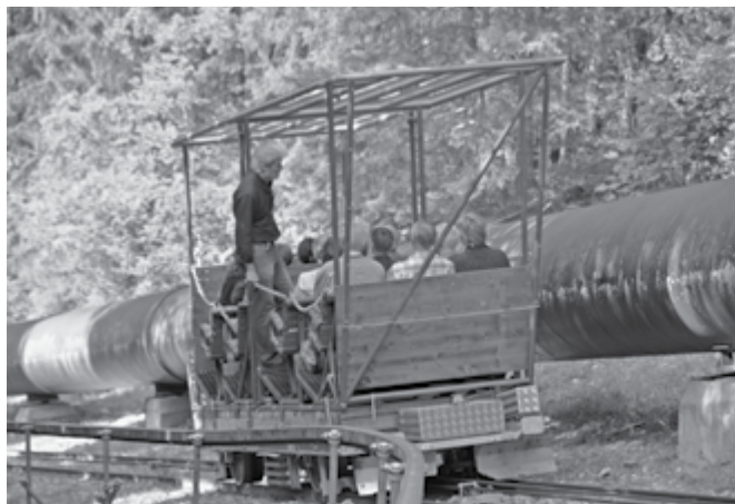
Die Zufahrtsbahn zum Kraftwerk Lünen, erbaut vor dem Ersten Weltkrieg, ist einmalig. Noch heute gibt es keine Zufahrtsstrasse.
