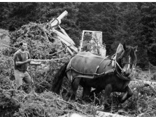
Rückeinsatz beim Bau der Sesselbahn Waldstafel mit Edel (2001). Um Platz für die Station in Waldstafel zu schaffen, wurden Bäume gefällt und entfernt. Auch auf den Hühnerköpfen, über der Waldgrenze, war der Einsatz der Pferde 2001 nötig: Wegen Schneefalls konnte das Material für den Innenausbau des Häuschens nur mit den Pferden hochgebracht werden.
